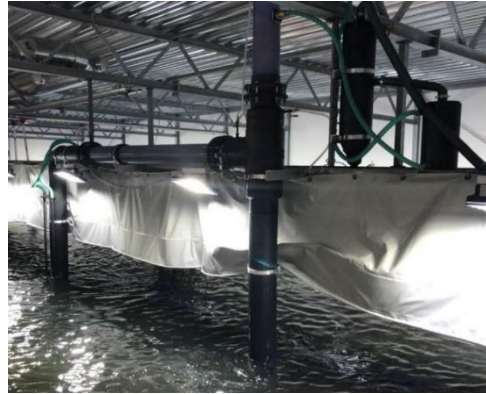
Fig. 3: Aquadukt installert i et kommersielt RAS.
